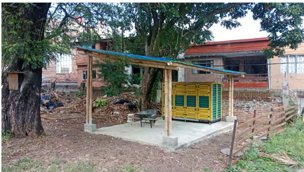
« Système autonome de compostage (SAC) permettant de transformer en engrais 4 500 kilos de déchets organiques par mois dans l'école IE Normal Farallones » (DAGMA, 2023).
