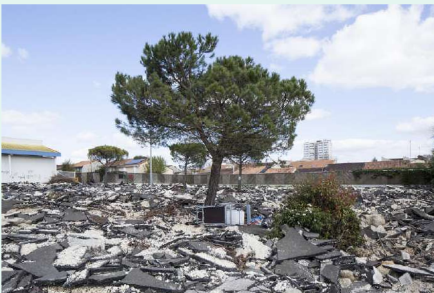
Décroutage - Ilot Castorama Mérignac Soleil – ©Sabine Delcour
