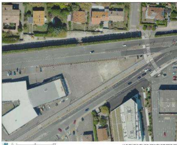
Avant la mise en place de la chaussée végétale, situation en 2023
