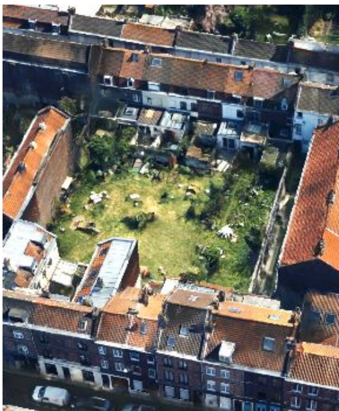
Vue aérienne d'une cour du quartier
