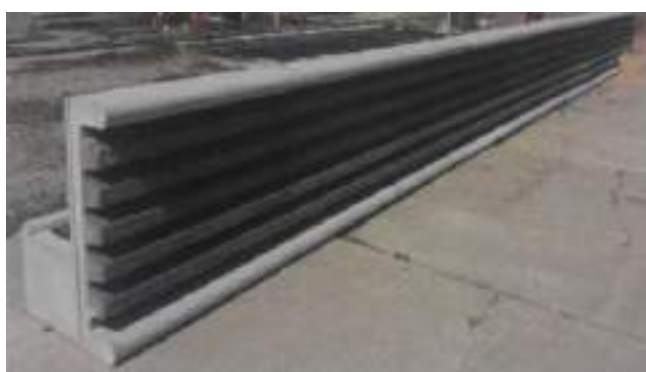
Ecran anti-bruit urbain PBM béton/béton-bois (source CIDB)
