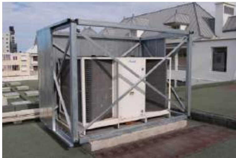
Traitement d'un condenseur par des écrans acoustiques
