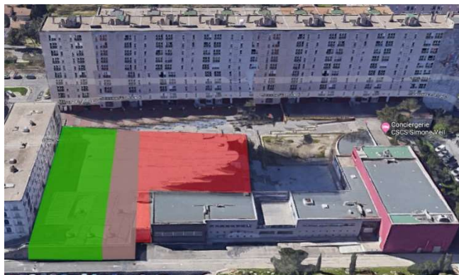
Zone de réhabilitation
