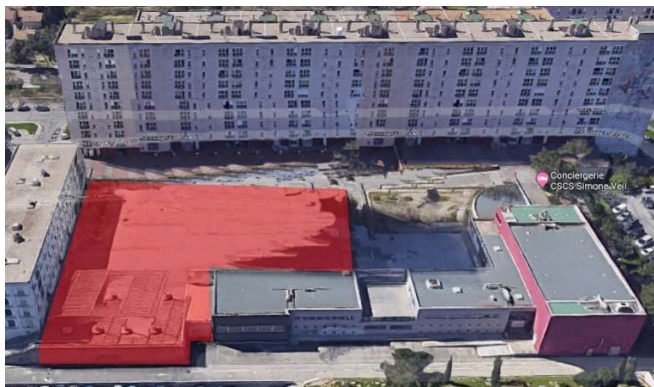
Zone de démolition
