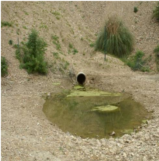
Figure 5 : Exutoire de la sablière dans la partie ouest du périmètre d'étude
