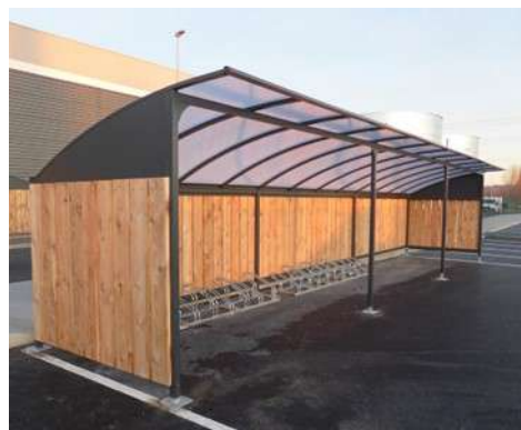
Abri-vélos pour entreprise à Sandouville (76)
