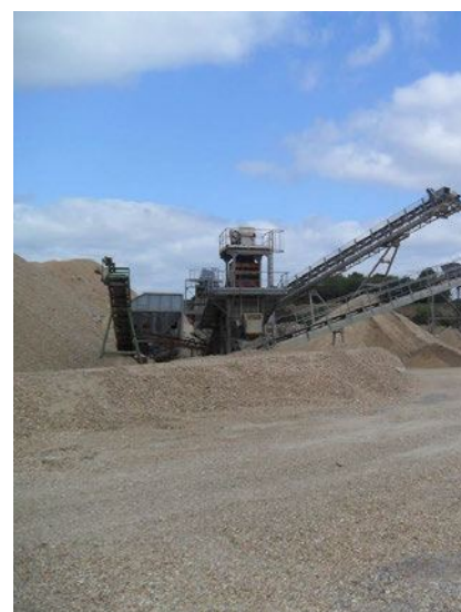
Figure 4 : Le site de production sablière et la machinerie en place
