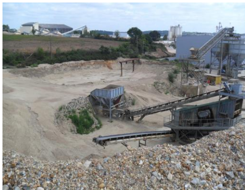
Figure 26 : Vue actuelle sur la sablière et la zone excavée du sud-ouest vers le nord-est
