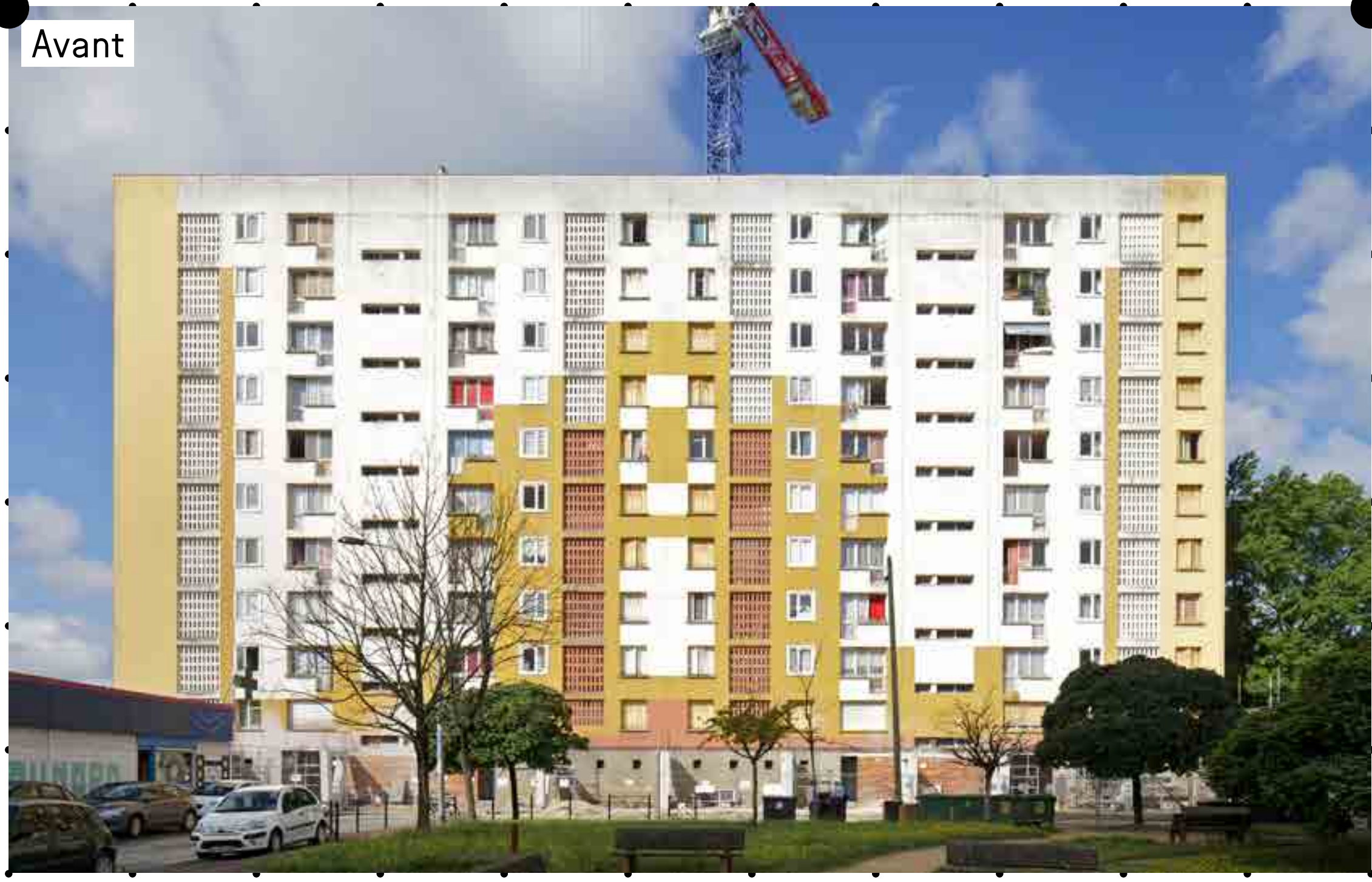
Avant Vue de l'immeuble avant les travaux de rénovation.
