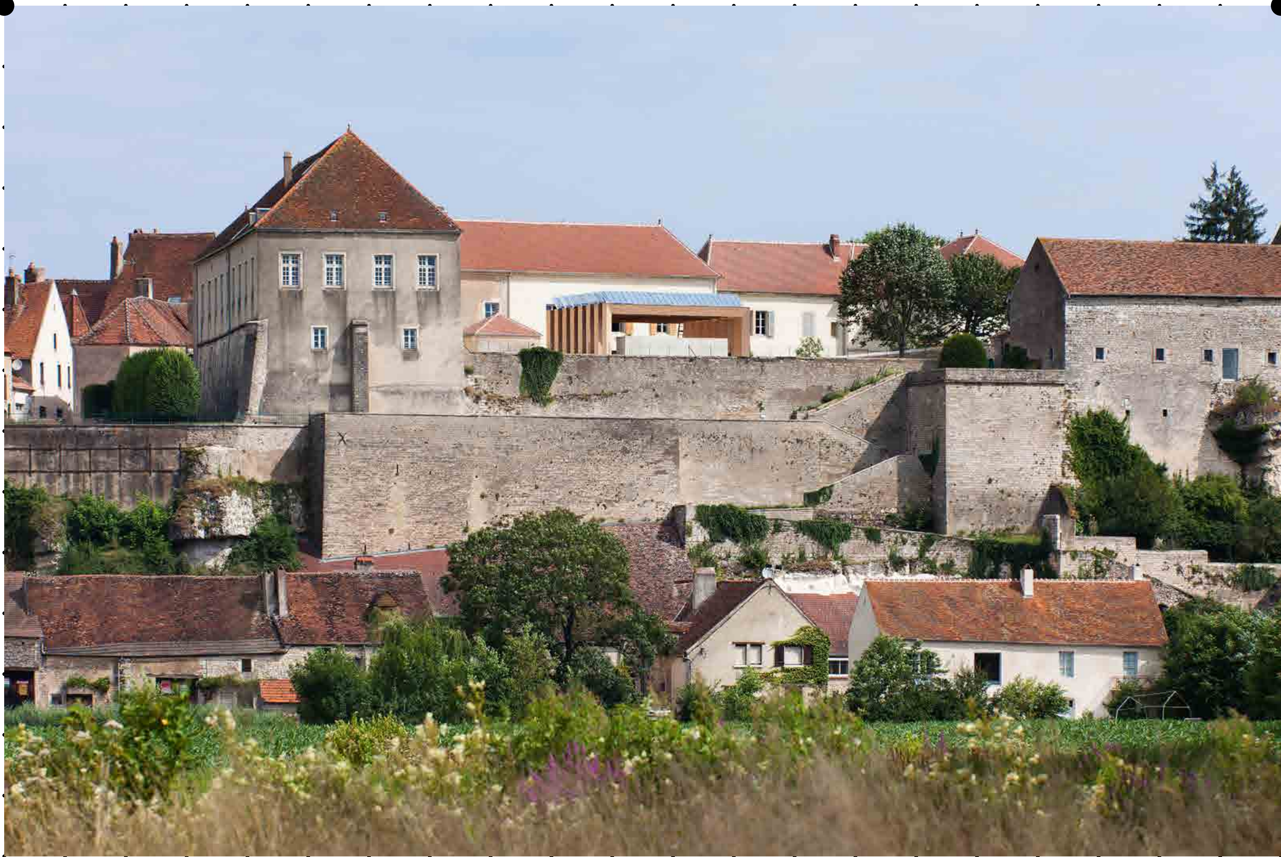
Vue sur les remparts historiques du château de Pesmes, qui accueillent aujourd'hui l'école réhabilitée du village
