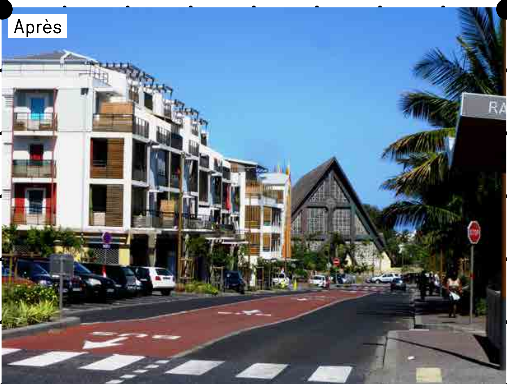
Rue du Père Favron avant et après son réaménagement
