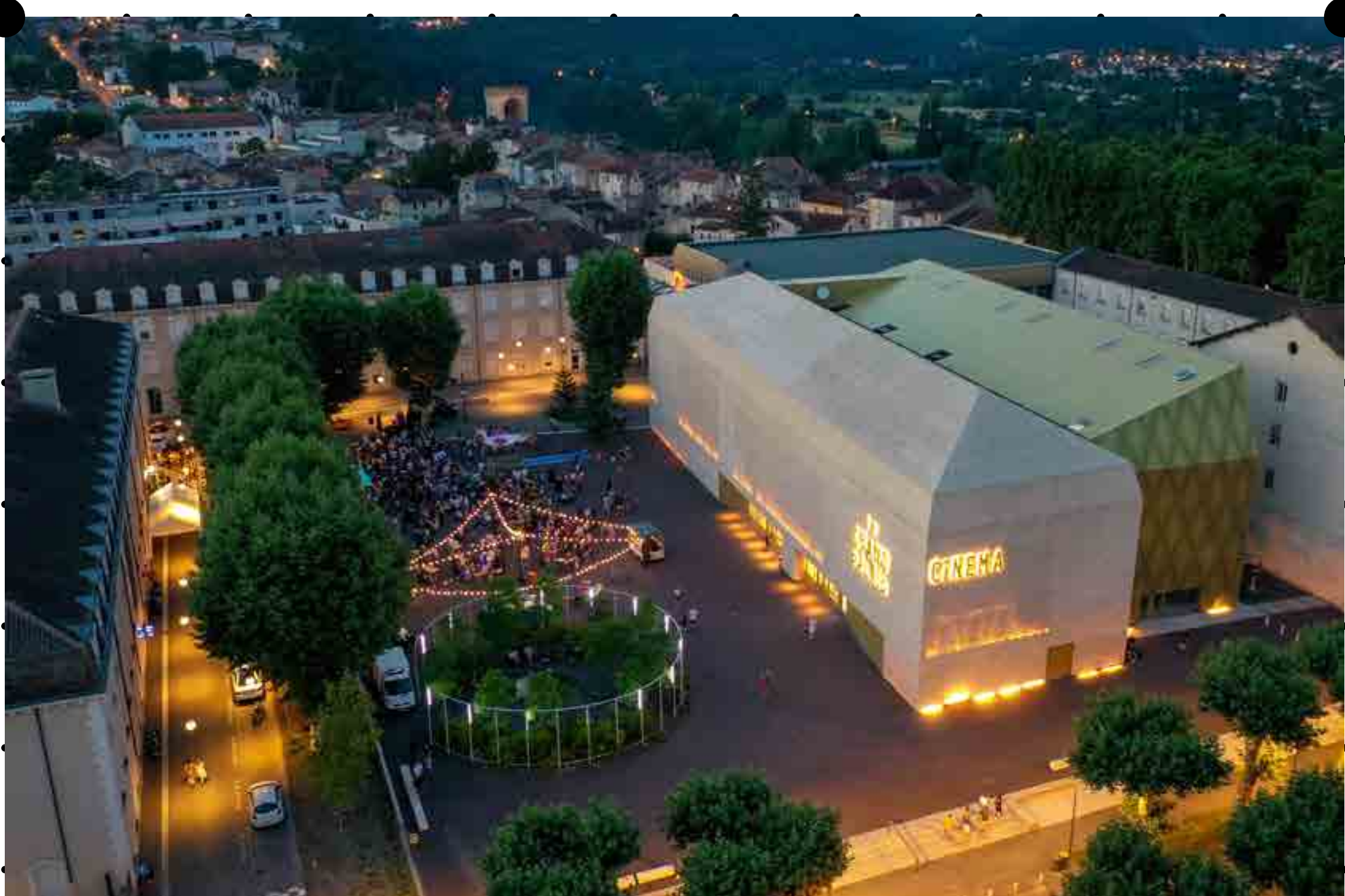
La place Bessièrès renaturée et son nouveau cinéma de centre-ville
