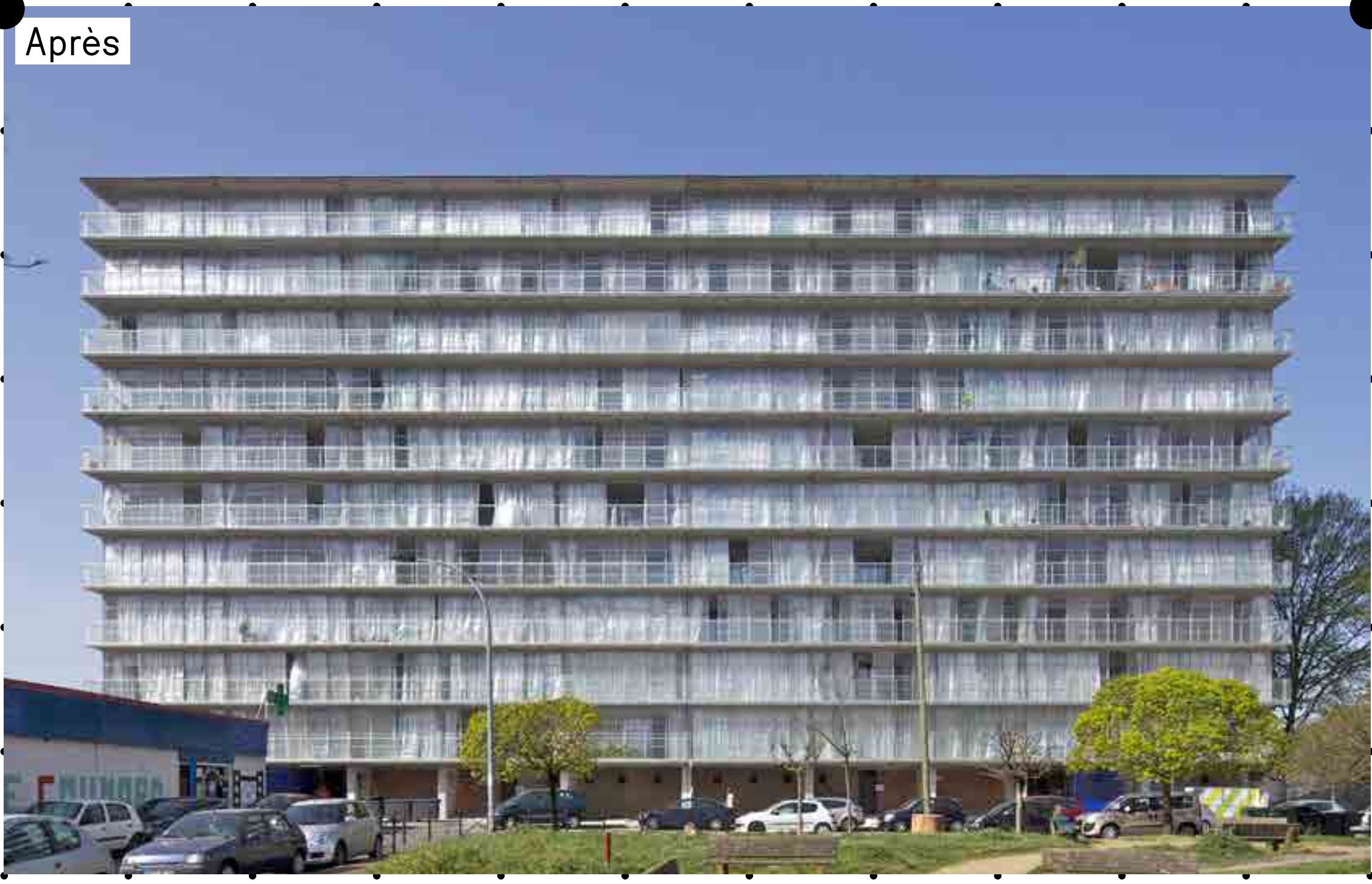
Après Ajout d'une nouvelle façade.
